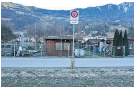
Ausgerissenes Verkehrssignal Dreiangelweg.
